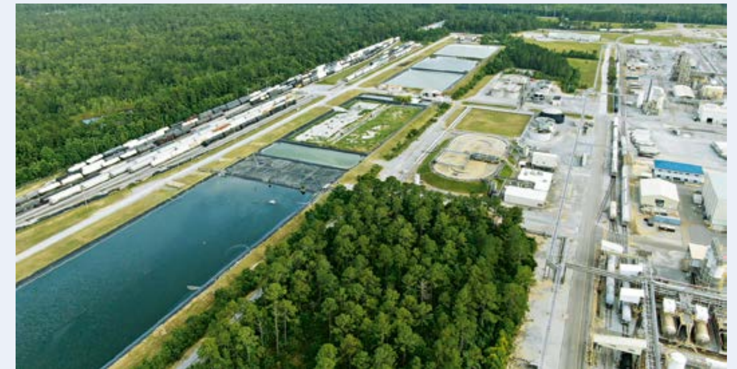
Sumpf ist Trumpf: 4,5 Millionen Liter Abwasser werden am Standort Mobile täglich aufbereitet. Bevor sie in einen Kanal geleitet werden, durchlaufen sie eine Sumpfkülaranlage (Bildmitte).
