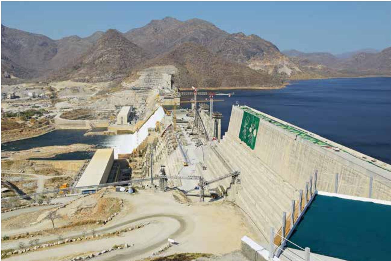
Stromstreit: Die Große Talsperre der Äthiopischen Wiedergeburt staut den Blauen Nil, was für Konflikte mit dem Sudan und Ägypten stromabwärts sorgt. Die ersten Turbinen des angeschlossenen Kraftwerks gingen Anfang 2022 in Betrieb.
