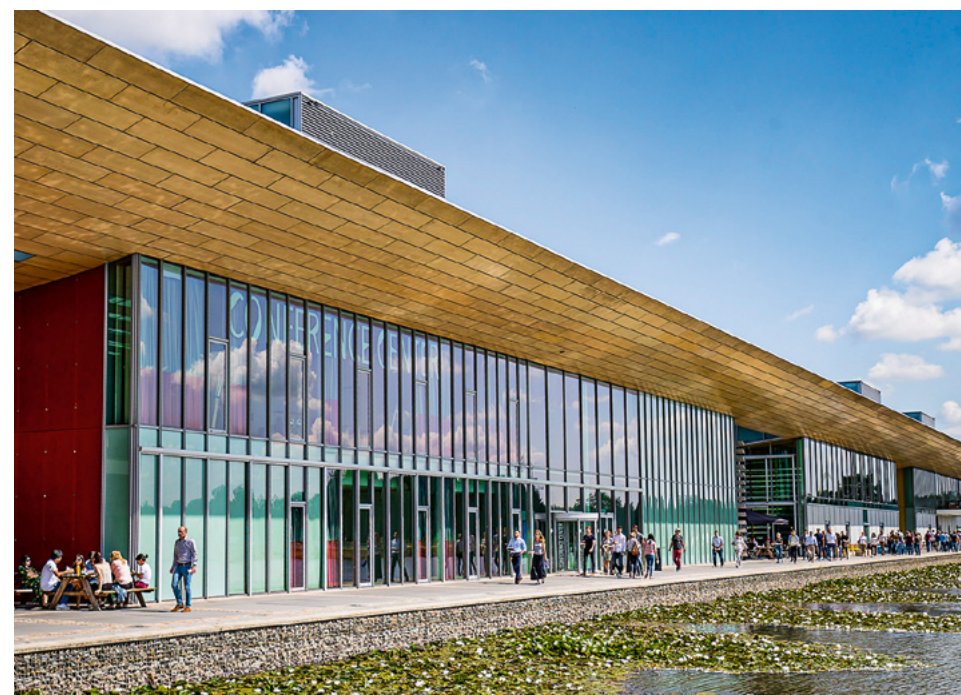
Der High Tech Campus am Stadtrand von Eindhoven ist Heimat zahlreicher Technologiefirmen, darunter auch Heat-Insyde.
