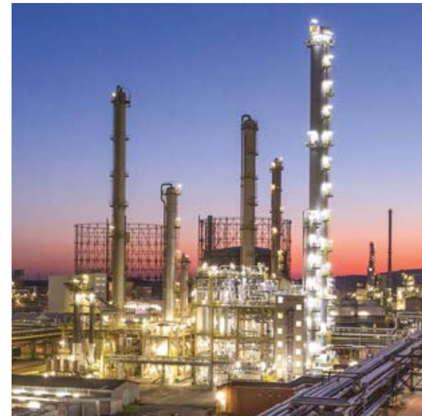
Die neue Anlage zur Aufbereitung von FCC-C4 im Chemiepark Marl
